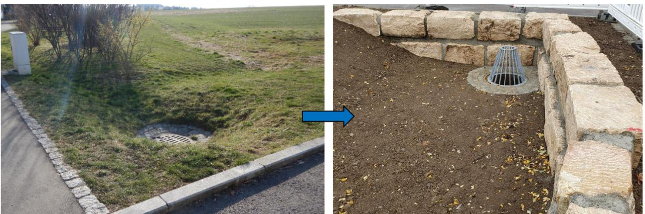
**Abbildung 16:** Verbesserung der Einlaufsituation am Bebauungsrand nach Aufstellung des SRRM (Umsetzung im Zuge der Sofortmaßnahme mit Herstellung der multifunktionalen Retention) [Büro Heberle]
