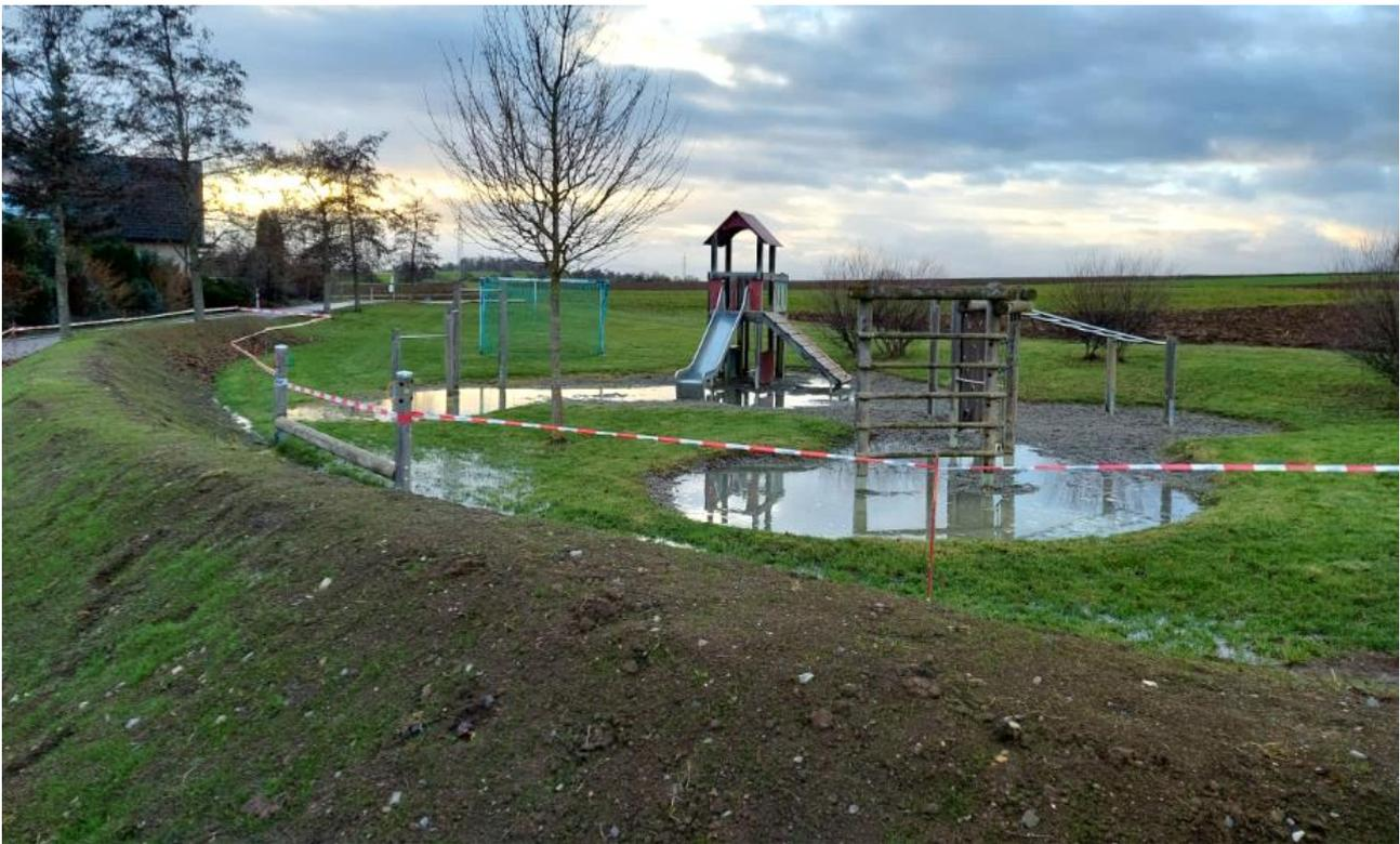
**Abb. 4:** Frisch eingesäter Erdwall nach Fertigstellung [Büro Heberle]
