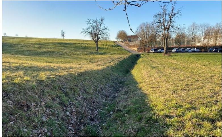
**Abbildung 28:** Leitstruktur zum Auffangen von wild abfließendem Hangwasser mit Ableitung in den Regenwasserkanal [RP Karlsruhe]
