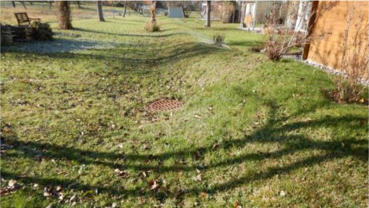
**Abbildung 26:** Erdwall in Kombination mit einer Abflusssmulde mit Ablauf in die Kanalisation [Büro Heberle]
