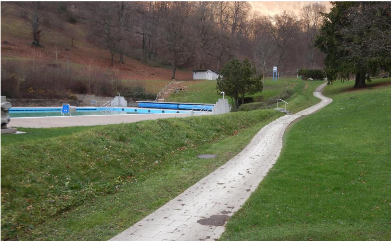
**Abbildung 25:** Erdwall zum Schutz eines Freibads vor Hangwasser [Büro Heberle]
