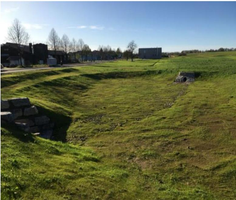
**Abbildung 35:** Abgrabung zur Rückhaltung von Oberflächenwasser [Büro Heberle]
