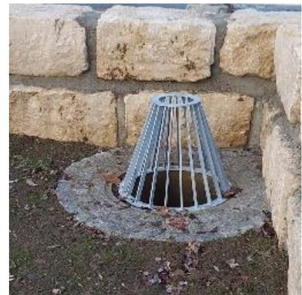
**Abb. 5:** Einlaufschacht mit Anschluss an die Mischwasserkanalisation [Büro Heberle]
