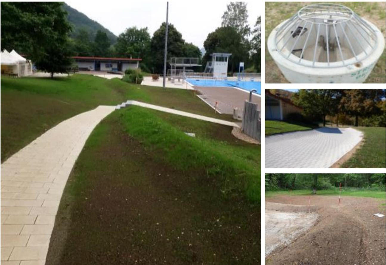
**Abb. 3:** SRRM Maßnahmenkonzept – Kleinschutz- und Leitstruktur (links), Einlauf Entlastung (oben), Pflastermulde (mittig), Verwaltung im Bau (unten) [Büro Heberle]
