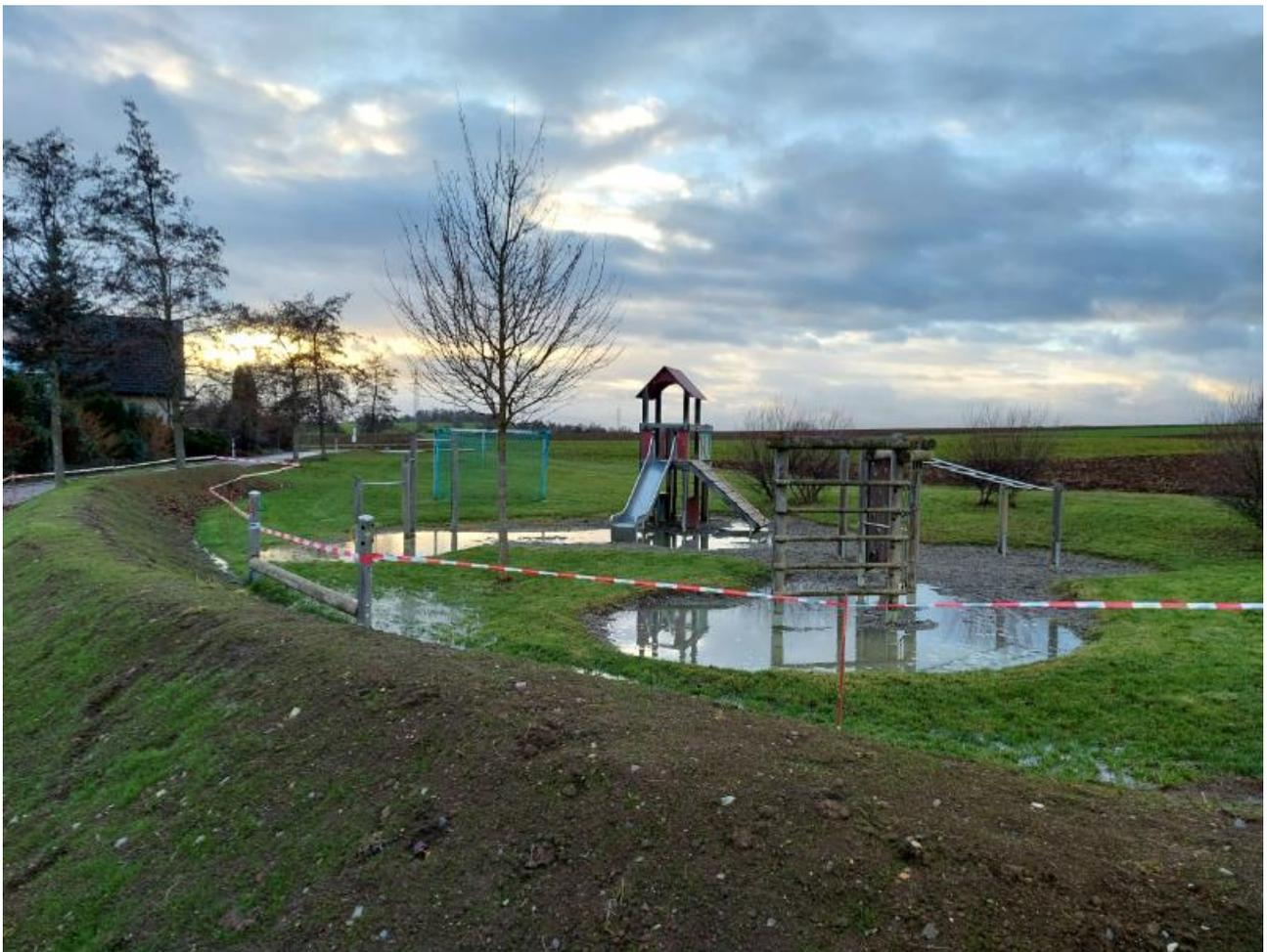
**Abbildung 33:** Öffentlicher Spielplatz wird in Kombination mit einer Verwallung zur Rückhaltung von wild abfließendem Wasser genutzt [Büro Heberle]
