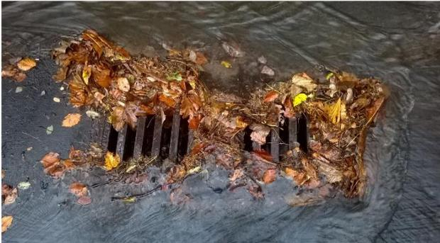
**Abbildung 21:** Durch Laub zugesperrter, seitlich umströmter Doppel-Einlauf [Stadt Karlsruhe, Tiefbauamt]
