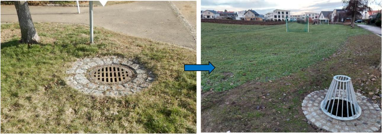
**Abbildung 14:** Rundeinlauf zur Fassung von Außengebietswasser wird mit Domschachtaufsatz umgebaut [Büro Heberle]
