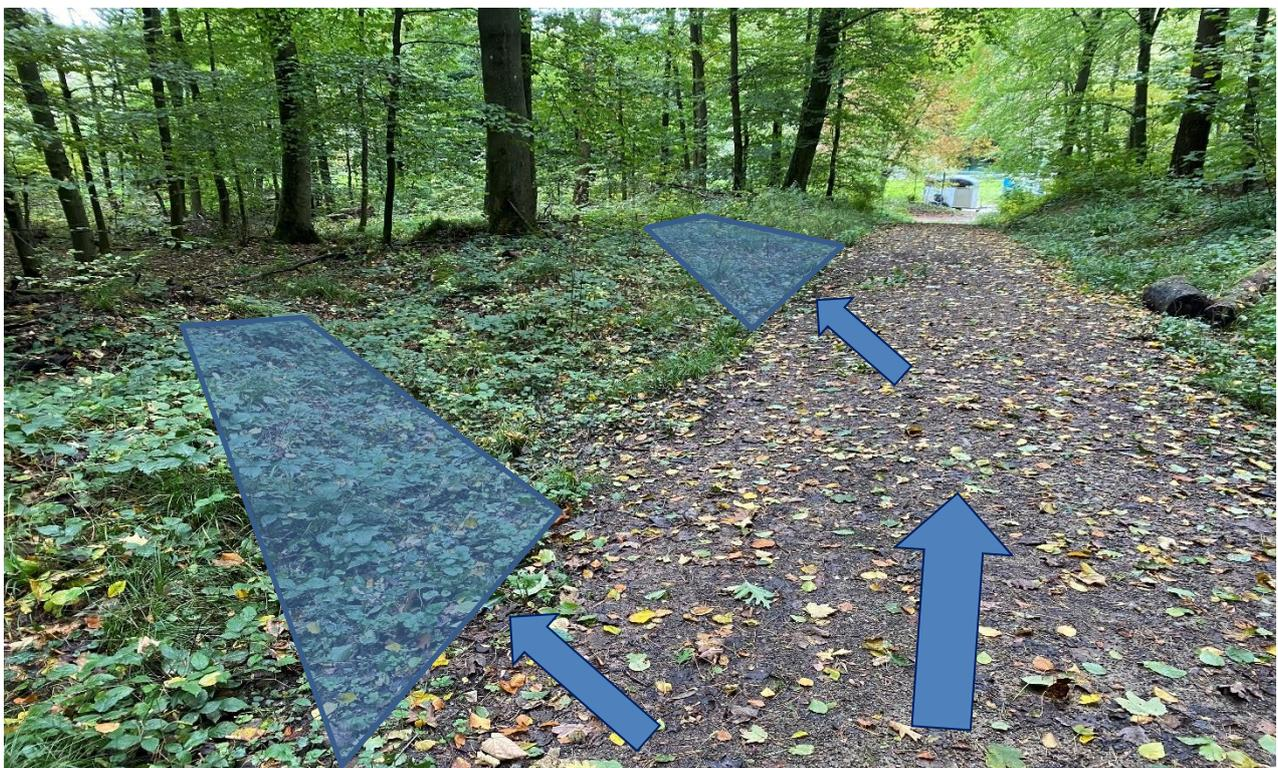
**Abbildung 5:** Durch Anlage mehrerer Abschlagsmulden an einem Wirtschaftsweg im Wald wird der Abfluss in Richtung Siedlung reduziert [RP Karlsruhe]
