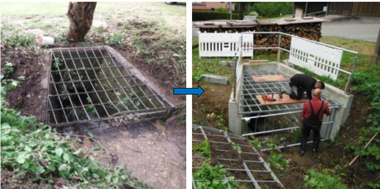
**Abbildung 15:** links: Alter Rechen vor Umbau; rechts: Räumlicher Rechen nach Umbau [LRA Ostalbkreis]
