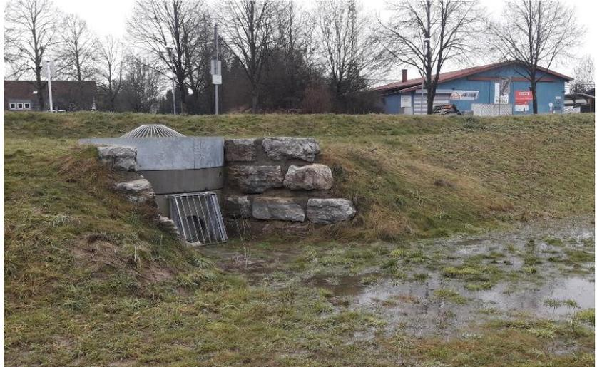
**Abb. 4:** Kombiniertes Drossel- und Entlastungsbauwerk [Büro Heberle]
