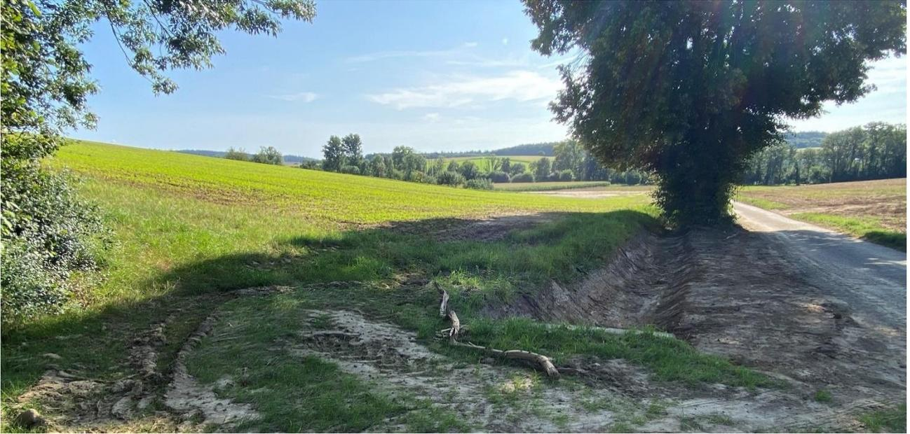
**Abbildung 23:** Geräumter Entwässerungsgraben nach einem Starkregenereignis mit erheblicher Bodenerosion und -ablagerung [RP Karlsruhe]
