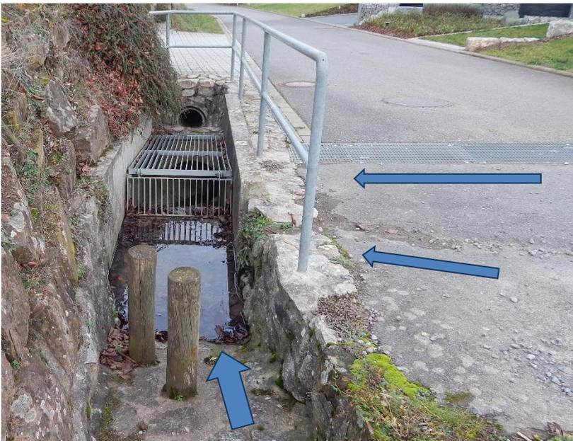
**Abbildung 17:** Niederschlagsabfluss aus dem Außengebiet wird auf verschiedene Weise gefasst (Querrinne und Wegneigung) und durch einen Geröllfang und räumlichen Rechen in die Kanalisation eingeleitet [Stadt Karlsruhe, Tiefbauamt]
