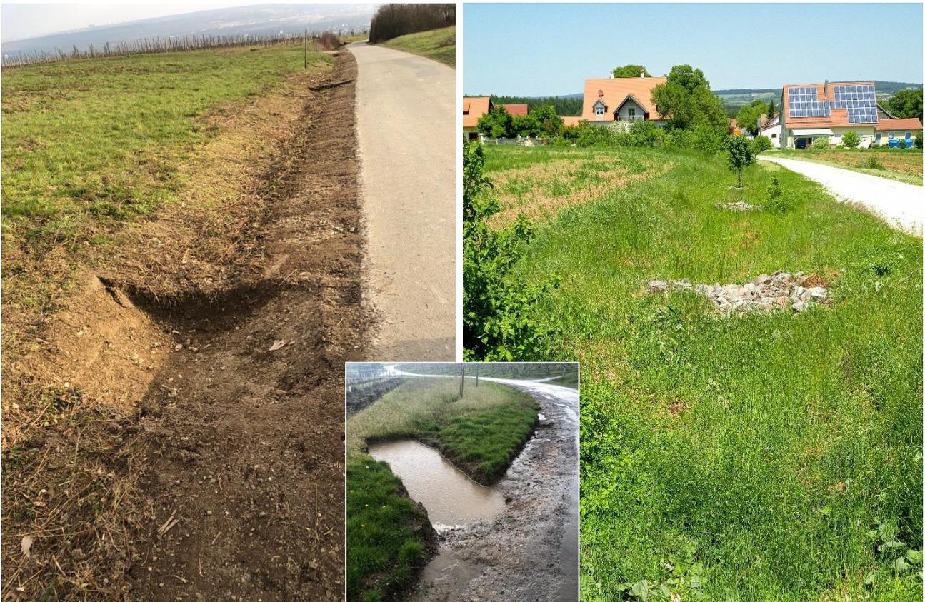
**Abbildung 4:** links: Entfernte Rasenwülste ermöglichen die breitflächige Ableitung des Oberflächenabflusses auf die mit kleinen Bodentaschen modellierte angrenzende Fläche; Mitte: Mit Oberflächenabfluss gefüllte kleine Mulde (Bodentasche) entlang eines Wirtschaftswegs [IB Blank]; rechts: Reduzierung der Fließgeschwindigkeit im Wegseitengraben durch mehrere Steinschüttungen [ALE Oberpfalz]
