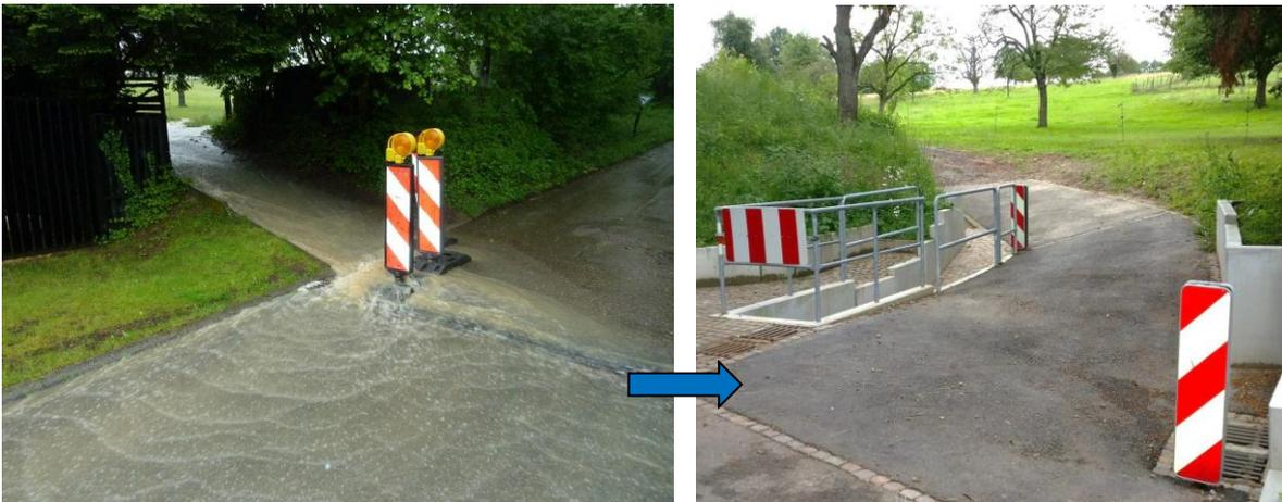
**Abbildung 13:** Die vorhandene Querrinne konnte das Oberflächenwasser bei Starkregen nicht mehr fassen. Durch Änderung der Wegneigung und Einbau eines räumlichen Einlaufbauwerks wurde die Situation optimiert [Stadt Karlsruhe, Tiefbauamt]
