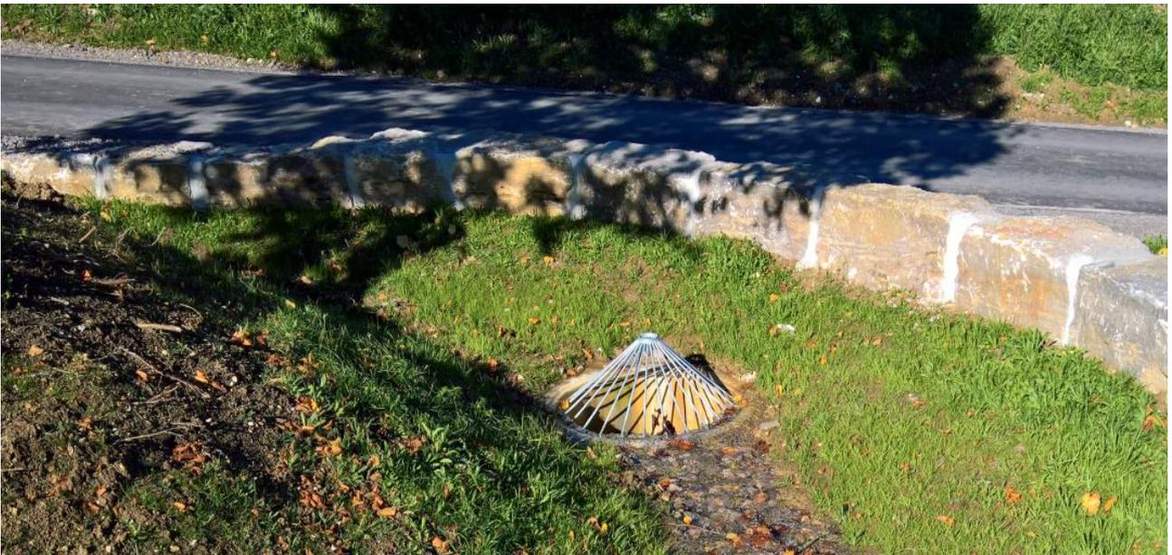
**Abbildung 27:** Kleinschutzstruktur (niedrige Mauer) am Siedlungsrand mit Fassung von Außengebietswasser [Büro Heberle]
