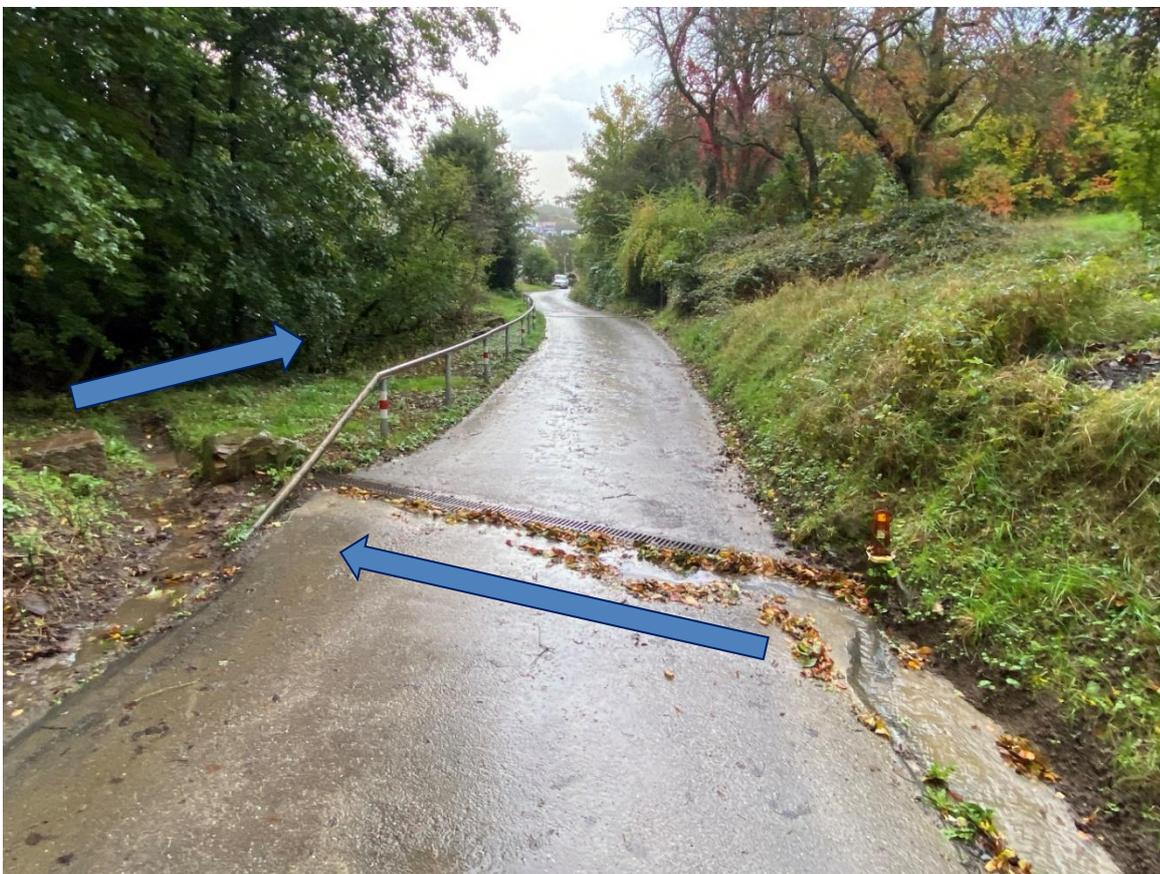
**Abbildung 9:** Abfluss wird über eine Querrinne zum Gewässer geleitet [RP Karlsruhe]
