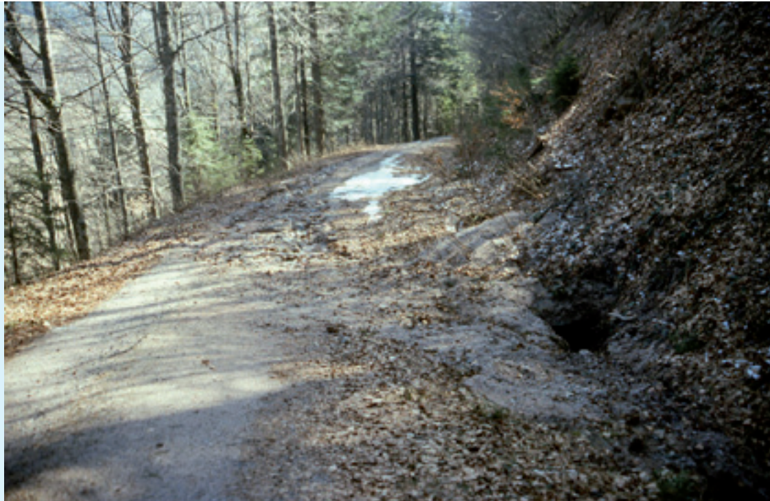
Abb. 30: Auffüllung der bergseitigen Böschung vor dem Doleneinlauf
