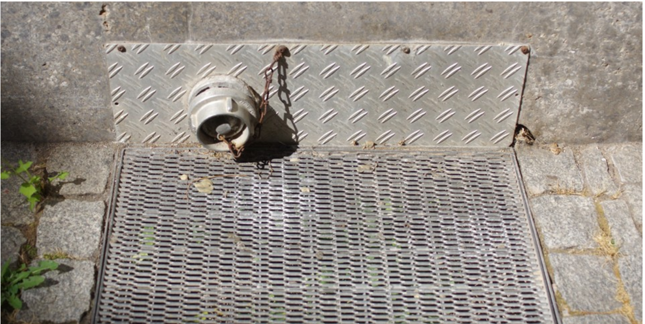
© Jürgen Gerhardt, xxdesignpartner.de Anschluss für einen Feuerwehrschauch zum Auspumpen eines Kellers
