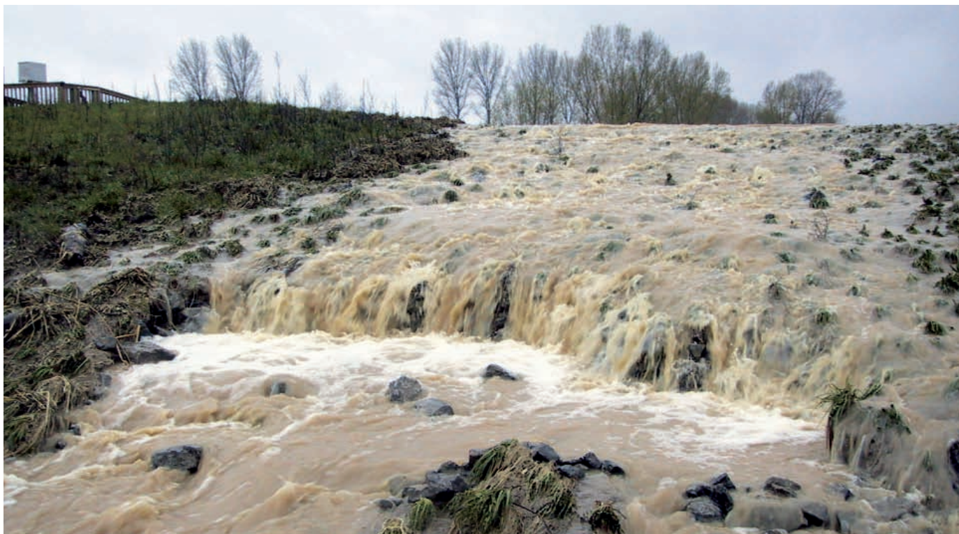
Abb. 18: Hochwasserentlastungsanlage im Betrieb (Überströmbarer Damm, HRB Raußmühle, Eppingen)
