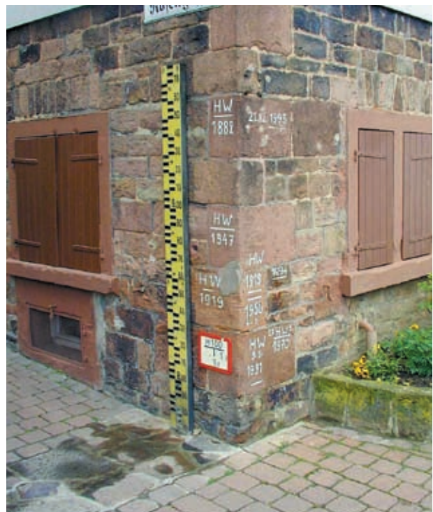
Abb. 15: Hochwassermarken in Eberbach am Neckar
