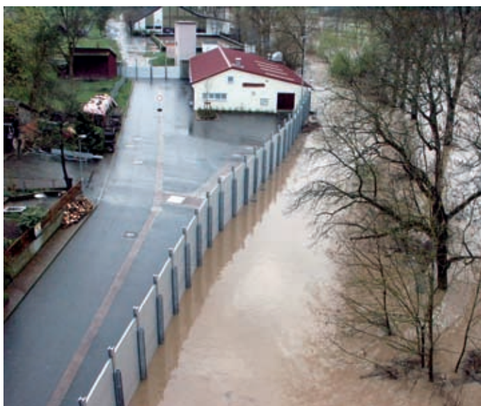
Abb. 27: Hochwasserschutzmaßnahme mit mobiler Schutzwand in Bad Friedrichshall (März 2002)
